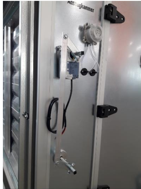
Abb. B – mit montiertem Stellantrieb
