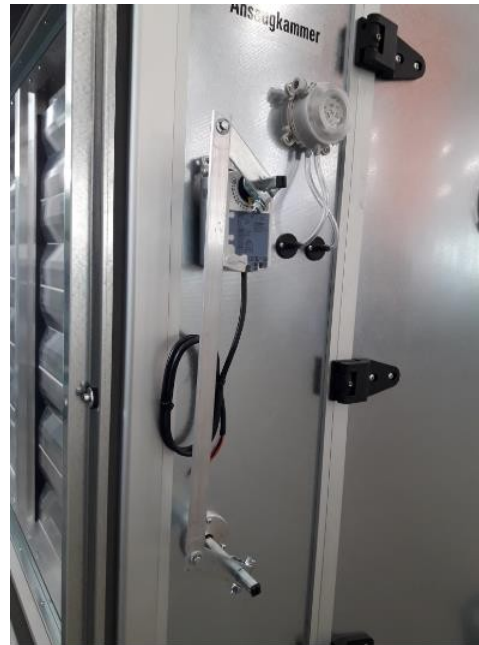
Afb. B – met gemonteerde servomotor
